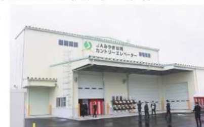
完成したカントリーエレベーター (宮城県角田市)
